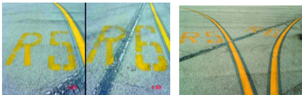
- 23 - Il bivio di rullaggio “R5” – “R6” ed i caratteri non a norma ICAO.
